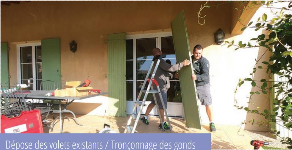
Dépose des volets existants / Tronçonnage des gonds
